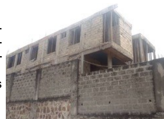
La maison en construction
